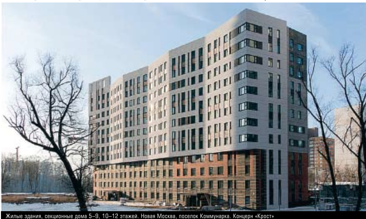
Жилые здания, секционные дома 5–9, 10–12 этажей. Новая Москва, поселок Коммунарка. Концерн «Крост»
