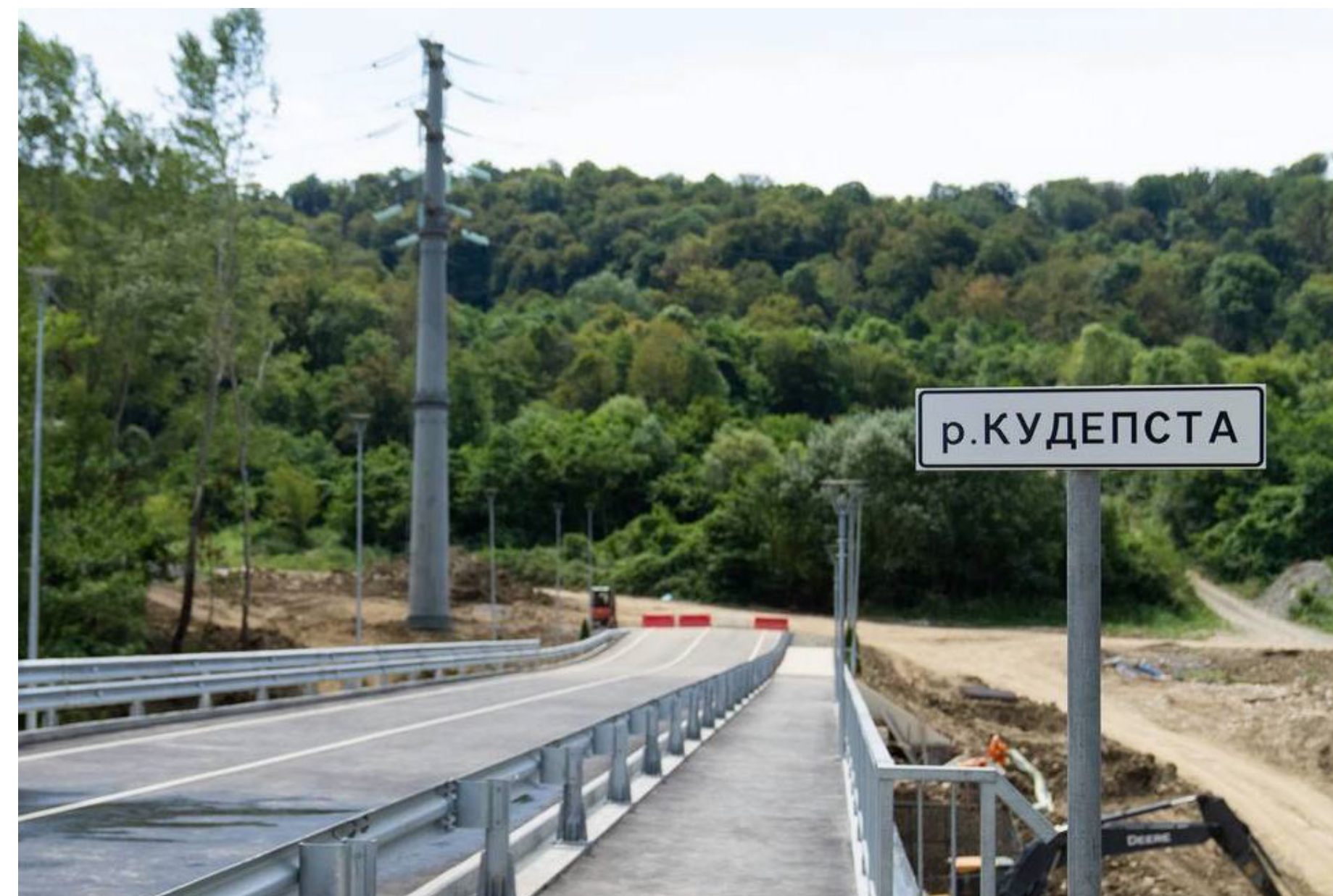
МОСТ ЧЕРЕЗ РЕКУ КУДЕПСТА
