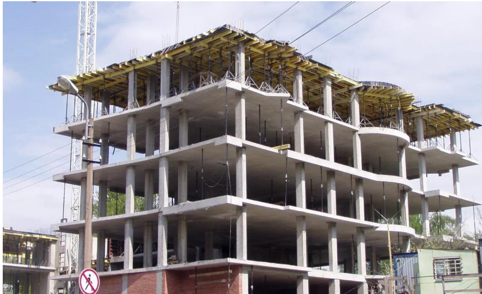
Бетоноемкость – 0,35 м.куб/ м.кв
