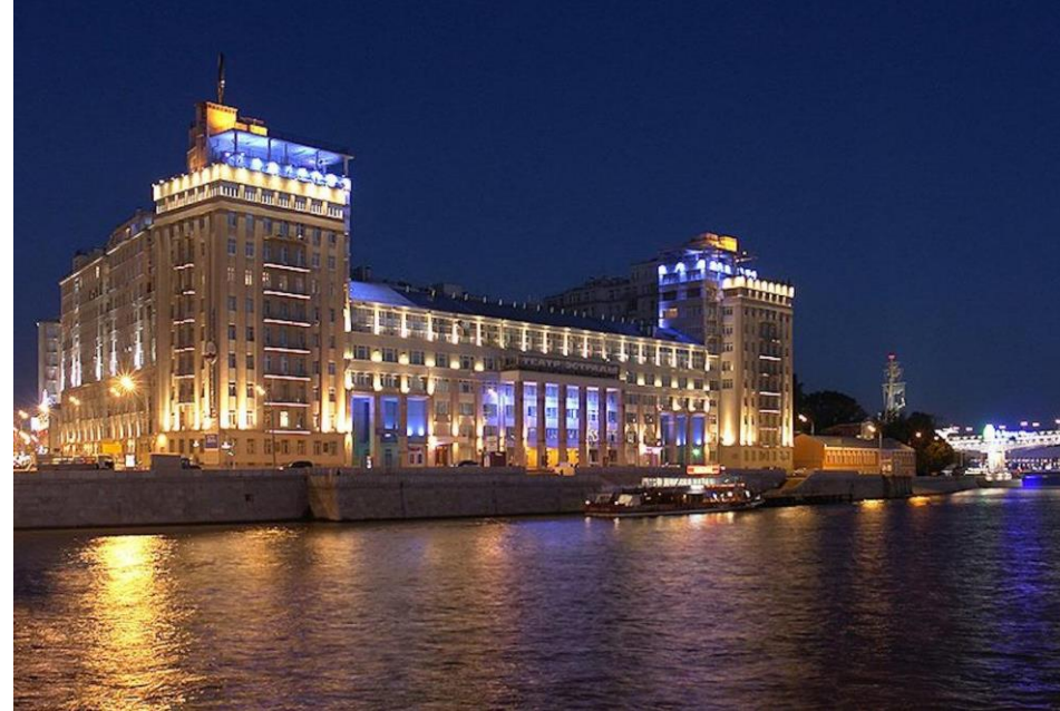
Дом на Набережной г. Москва, Берсеневская набережная 1928-1931 Многokвартирный дом
