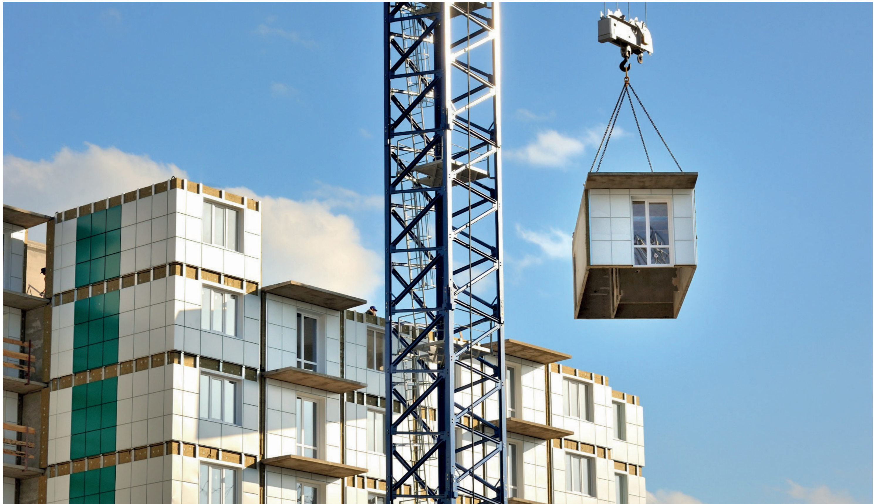
Установка модуля на строительной площадке
