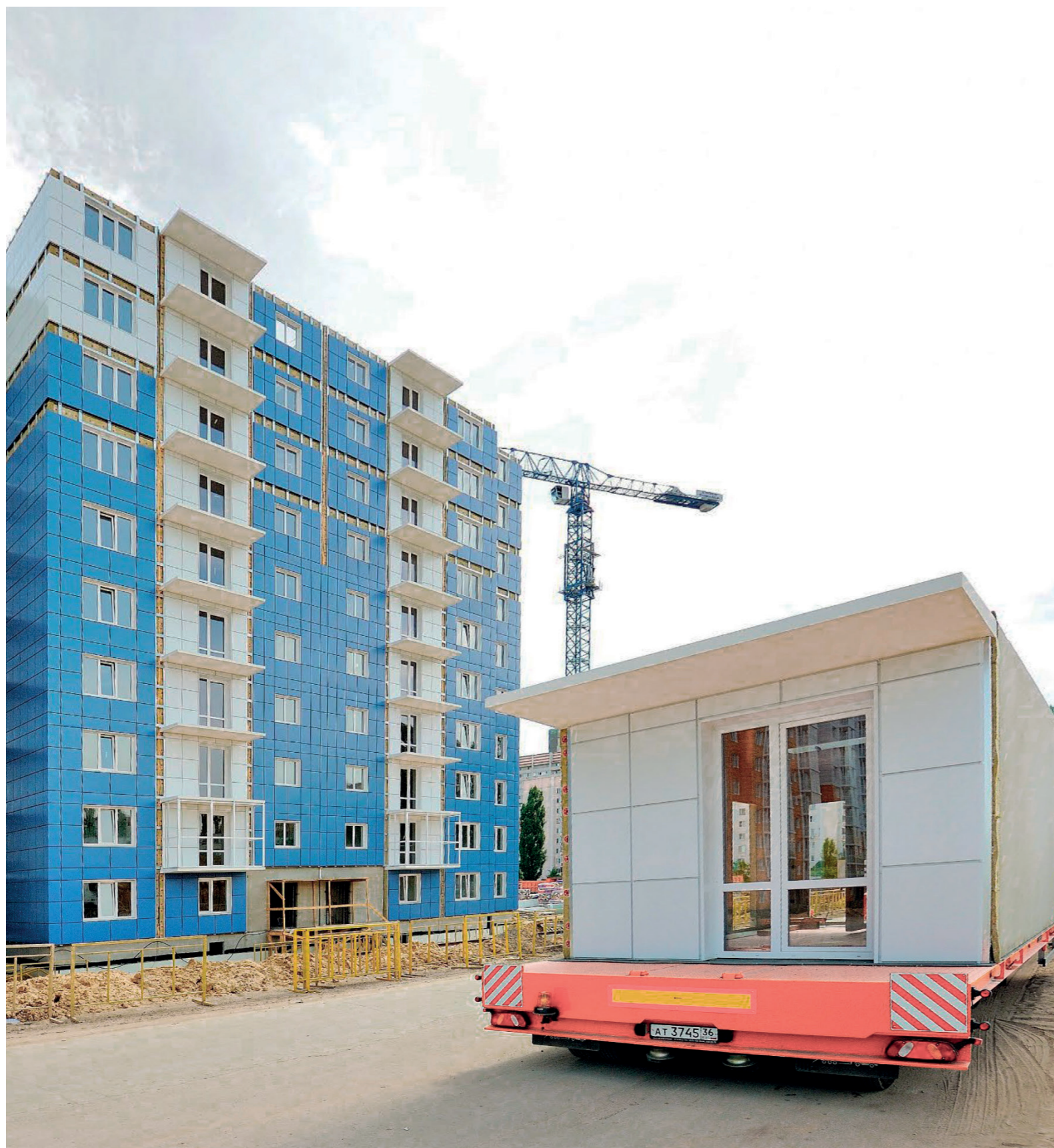
Подвоз и установка модулей на строительной площадке
