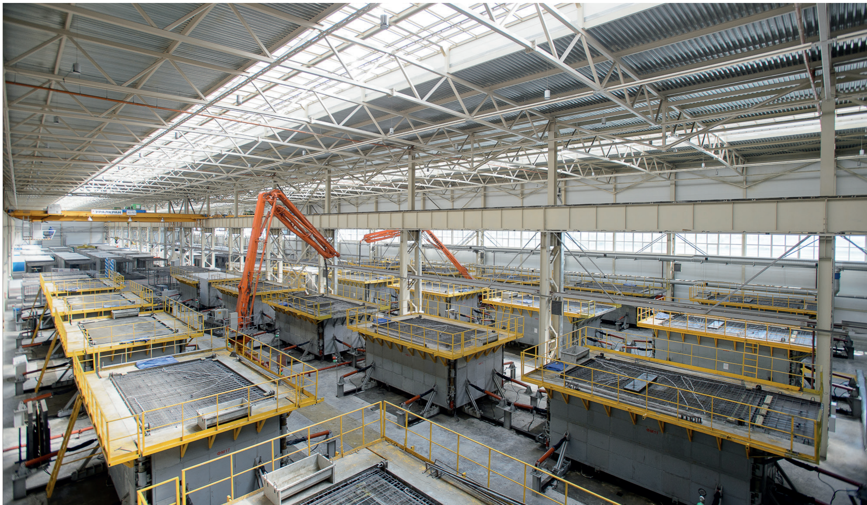
Подготовленные формовочные установки для заливки бетона
