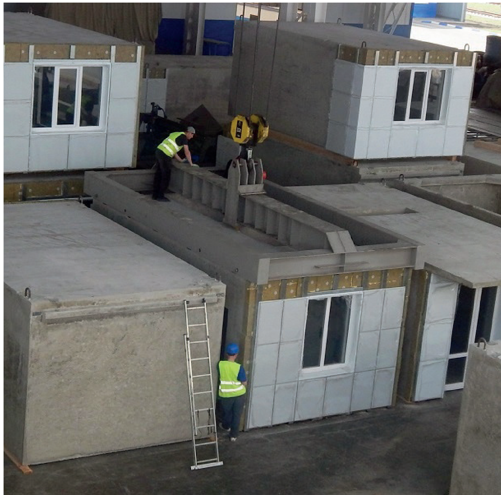
Подготовка к транспортировке готового модуля
