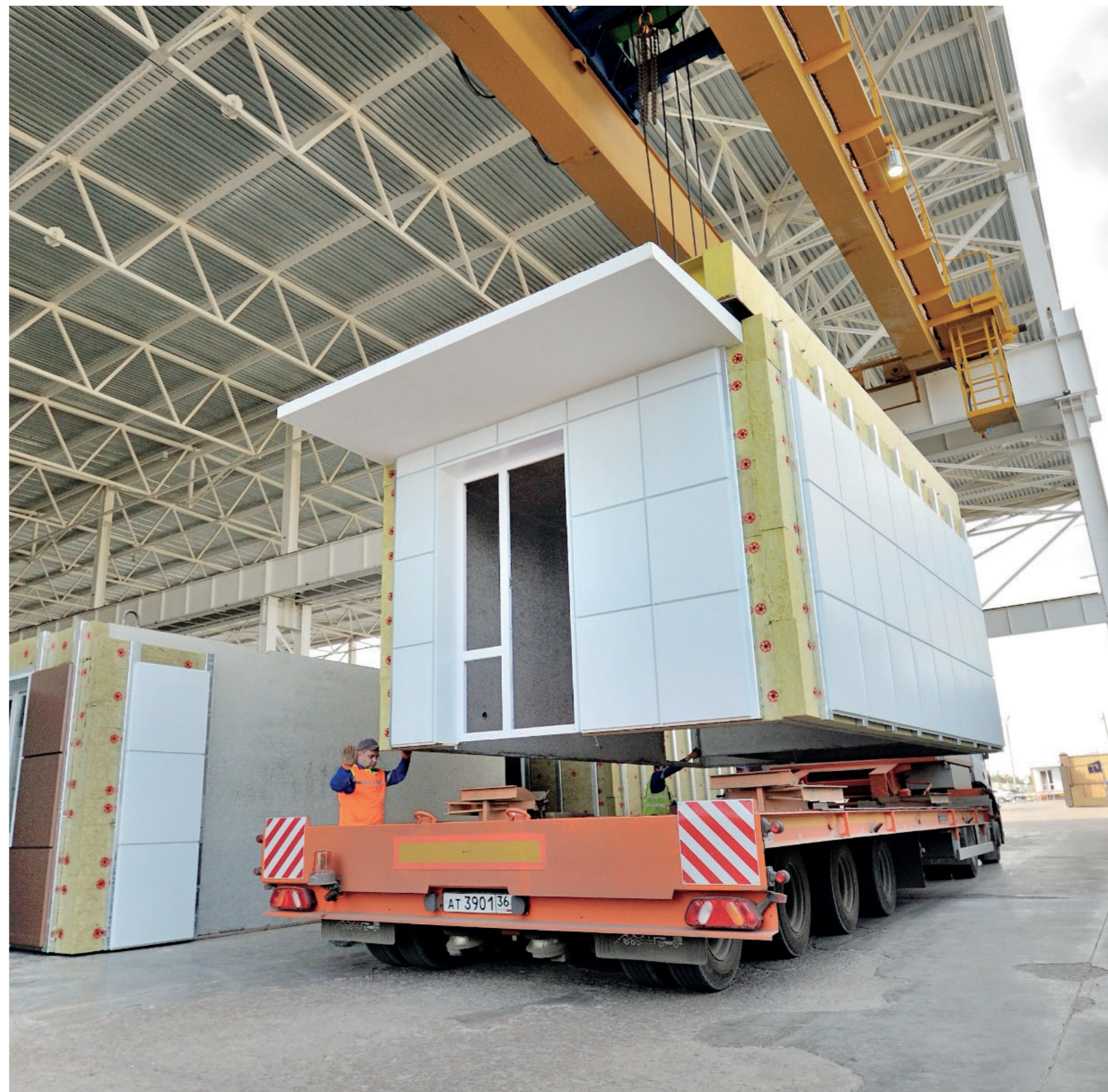
Погрузка модуля на трал
