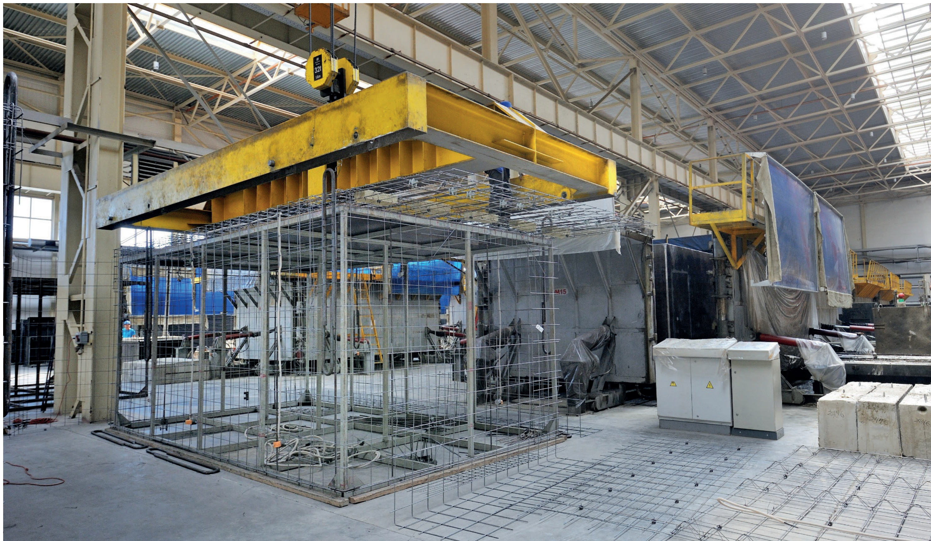
Процесс сборки и перемещения готового пространственного каркаса
