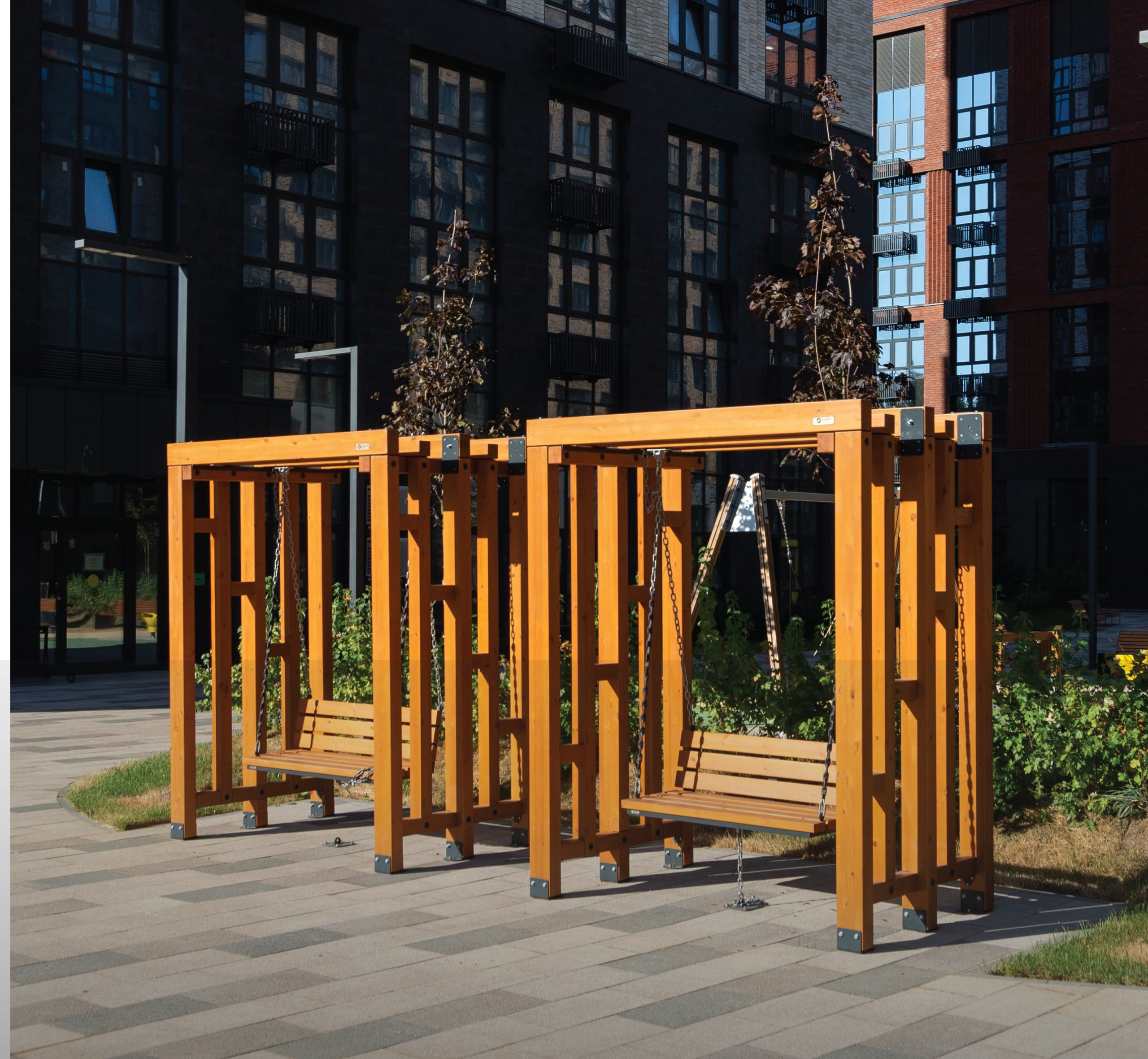
Реализация нестандартного решения крепления МАФ на стилобате методом анкерения к фундаментной плите.
