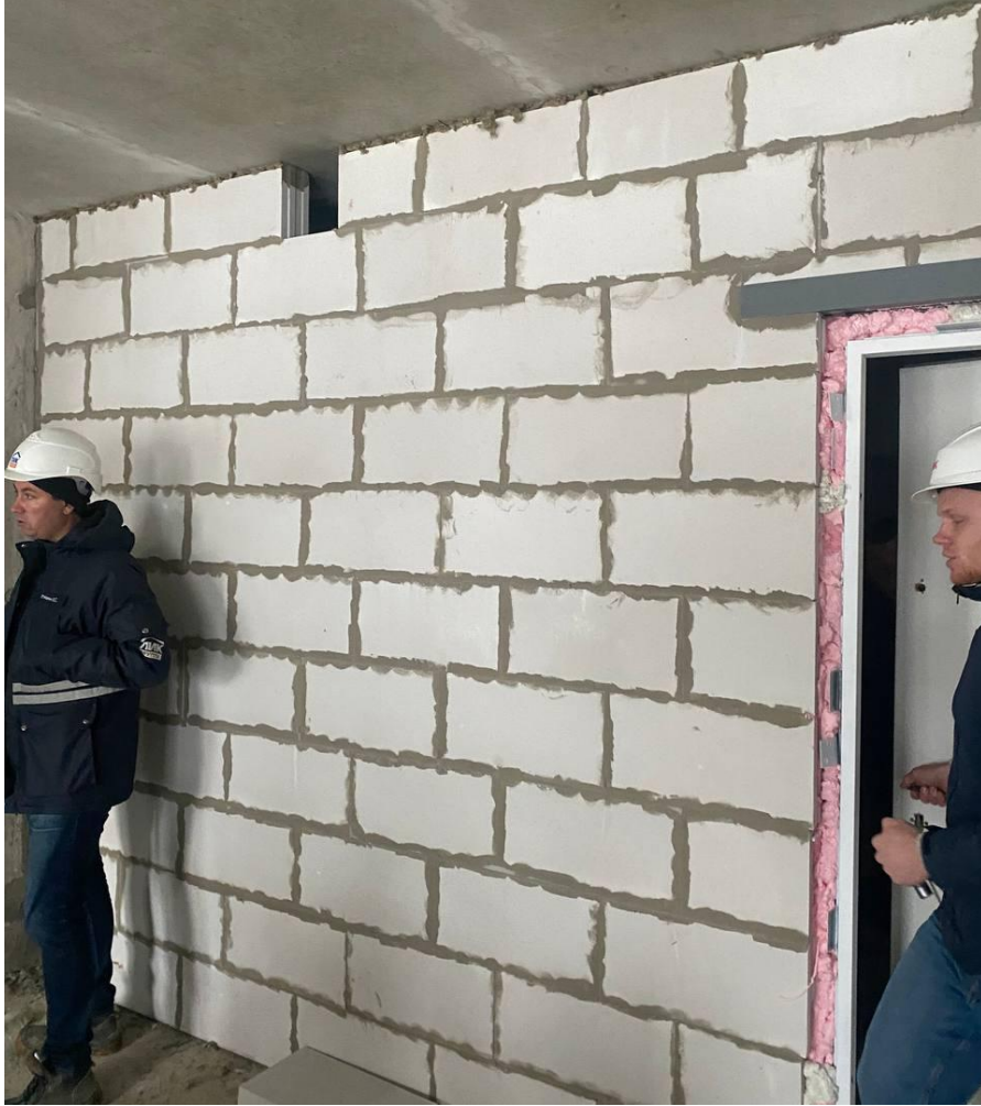
Общий вид кладки
