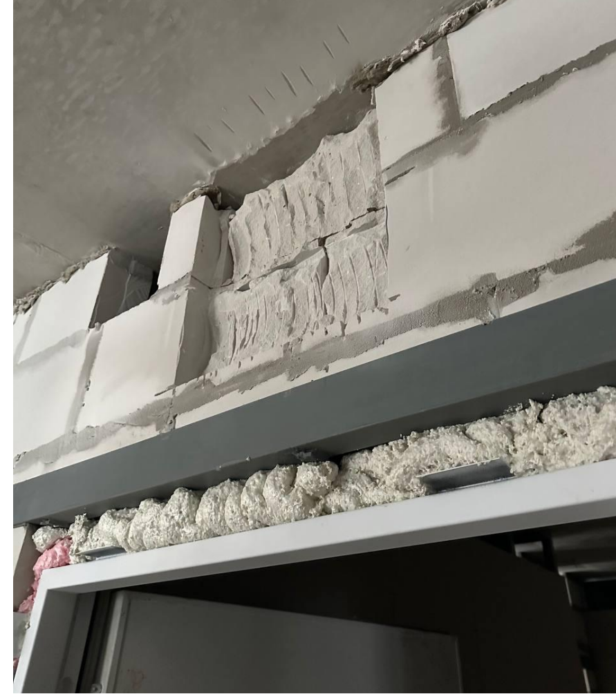
Ниша под электрический щиток
