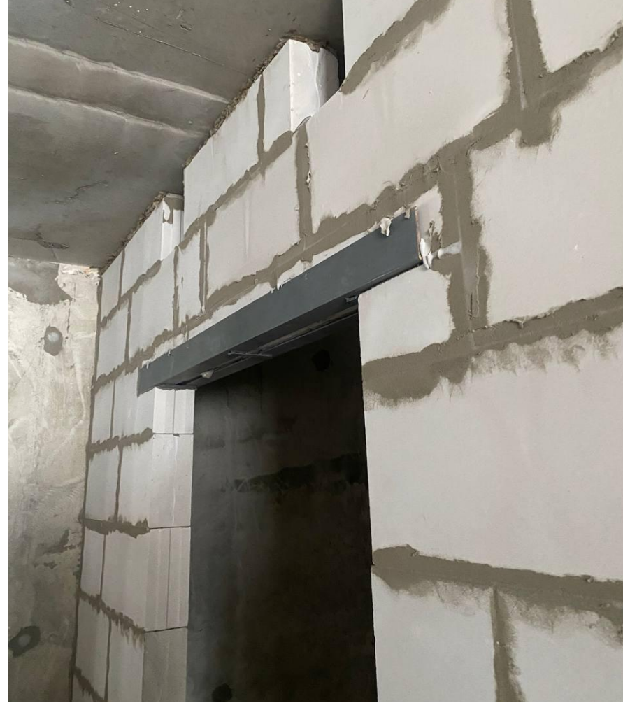
Узел усиления дверного проема и инженерных проходок
