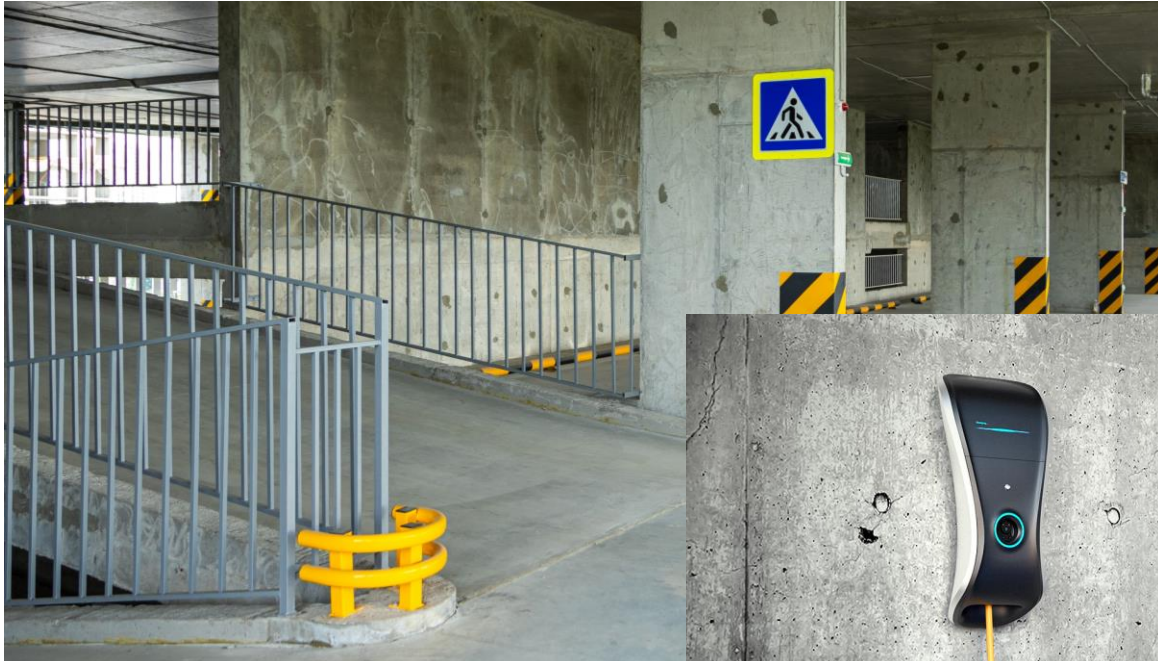
Ограждения и колесоотбойники
