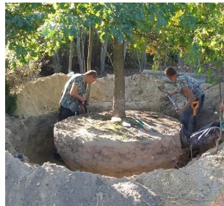
Транспортировка на объект и посадка
